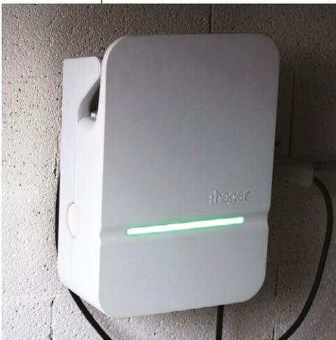
La borne de charge, quant à elle, peut communiquer à la voiture la puissance maximale que cette dernière peut demander. Cela se fait en modulant le rapport cyclique (durée à 12v et durée à -12v), autrement dit la borne effectue une modulation de la largeur d'impulsion. Par exemple, un rapport de 10 % correspond à une puissance maximale de 6A, 20 % correspondent à 12A, 50 % à 30A, cela va jusqu'à 96 % pour 80A.
