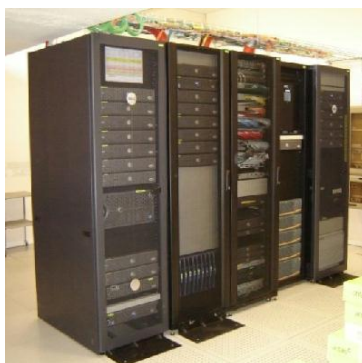
FIGURE 9.1 – Les baies informatiques permettent de « ranger » des serveurs physiques. Mais la place disponible n'est généralement pas extensible et les salles accueillant ces baies doivent être climatisées, placées dans un environnement électrique de confiance (onduleur). La virtualisation peut apporter une solution. (image d'une baie de serveurs à l'Université Toulouse 1 Capitole)
